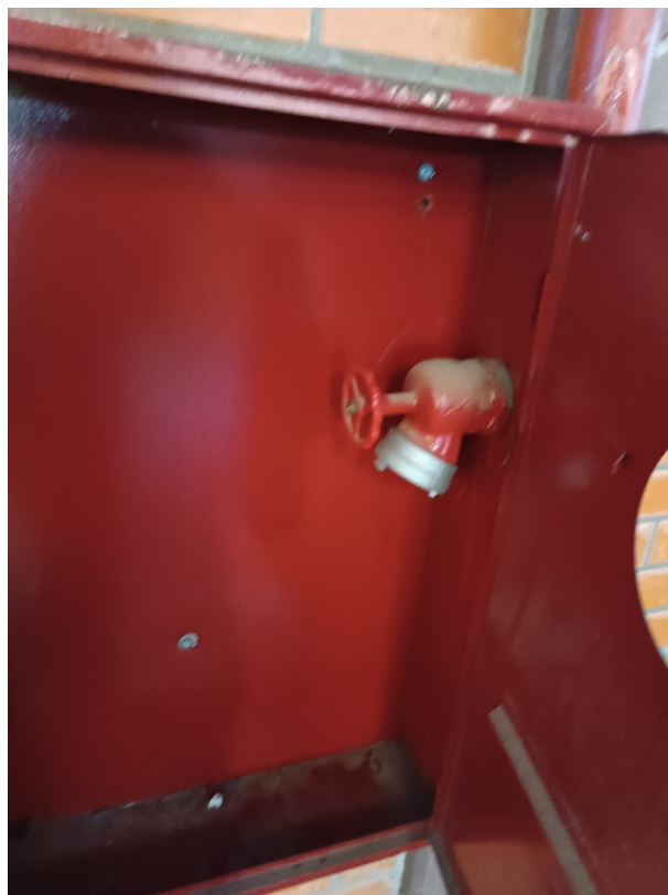
Foto 26 – Abrigo de hidrante sem as mangueiras
