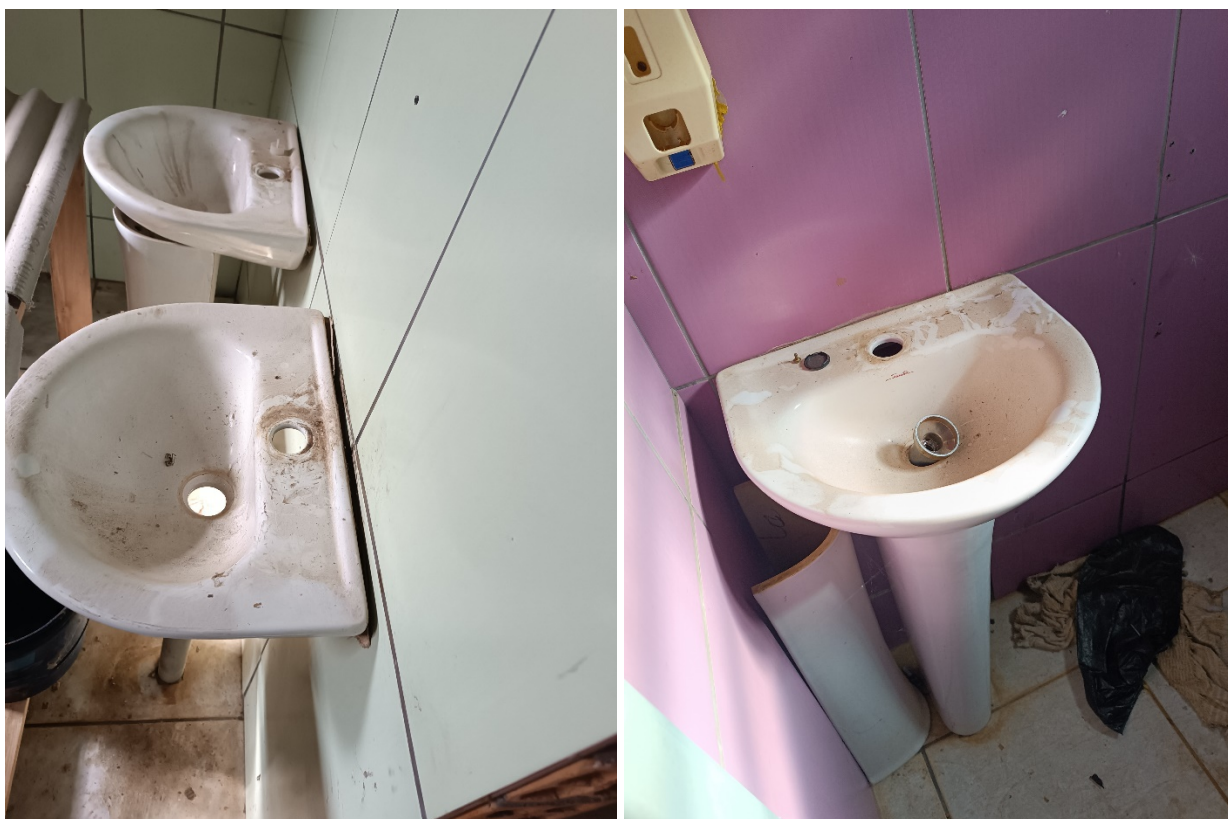
Foto 16 – Lavatórios sem torneiras e sifões
