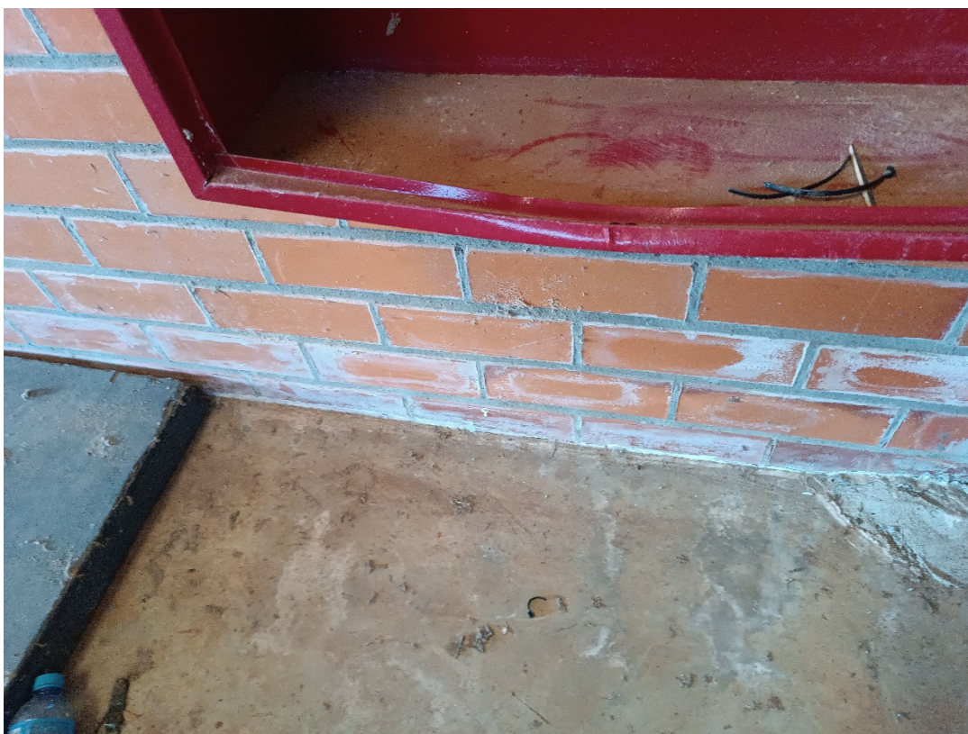
Foto 27 – Abrigo de hidrante amassado
