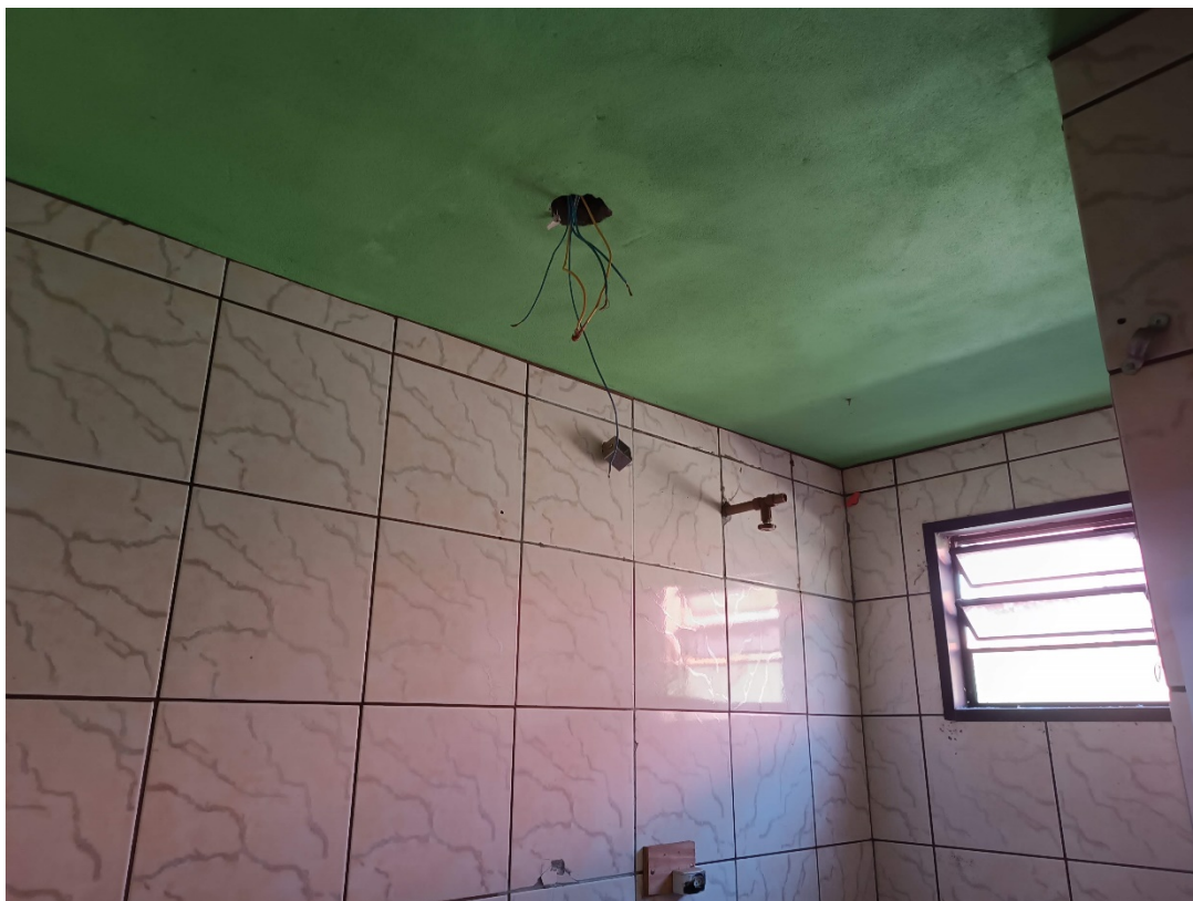
Foto 09 – Fiação exposta e ausência de lâmpada
