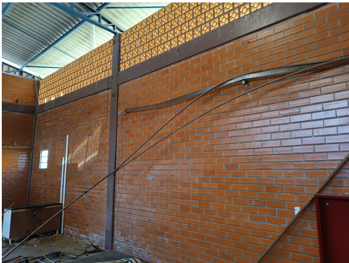
Foto 07 – Eletrocalhas incompletas e fiações expostas
