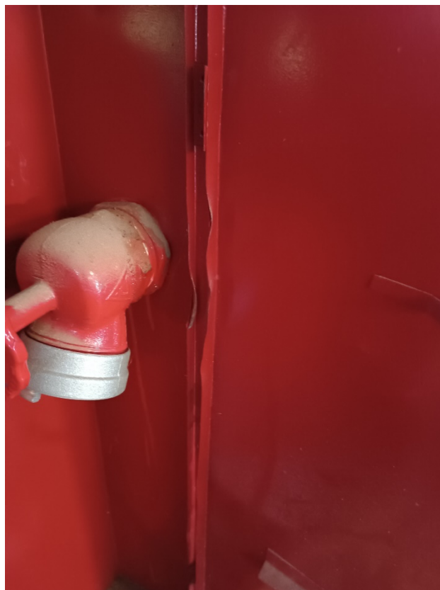
Foto 28 – Abrigo de hidrante sem mangueira e amassado
