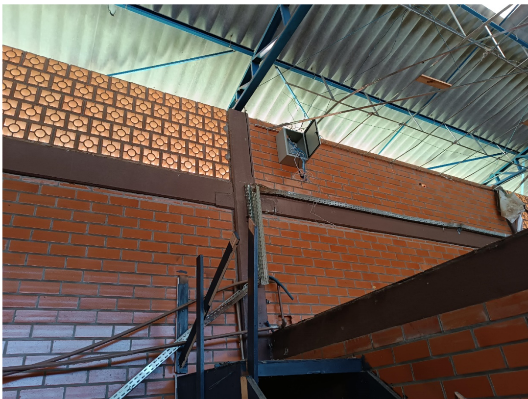
Foto 08 – Cabeamento exposto e eletrocalha destruída
