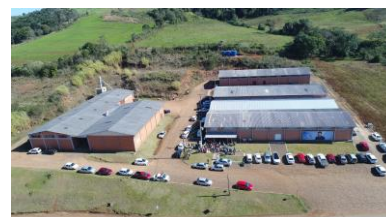
Figura 3. Condomínio Industrial - Saltinho, SC
