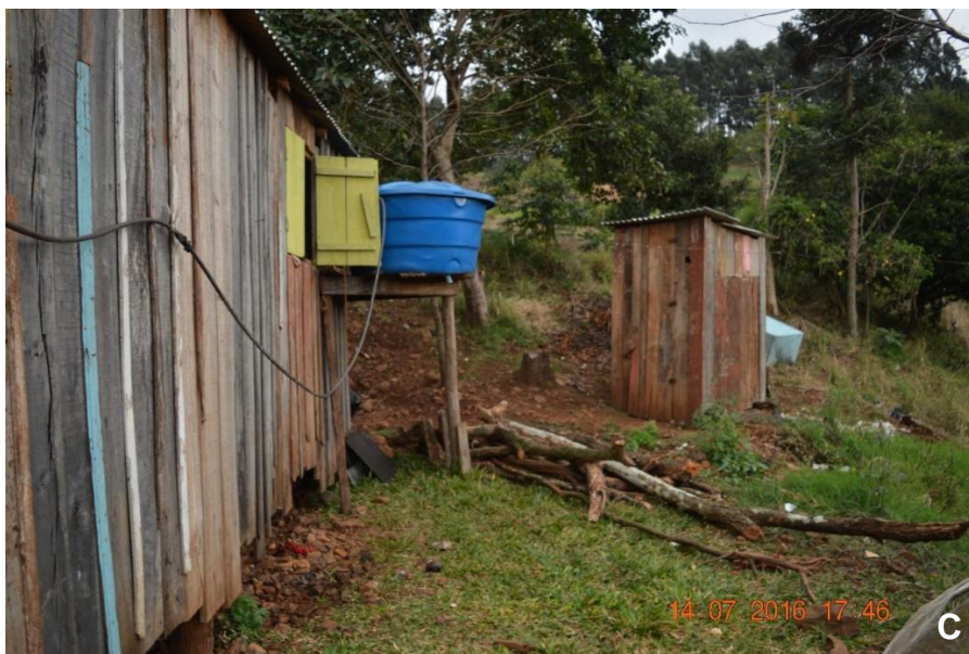
Figura 84. Edificação em área de risco do Ponto 119, Figura 77.
