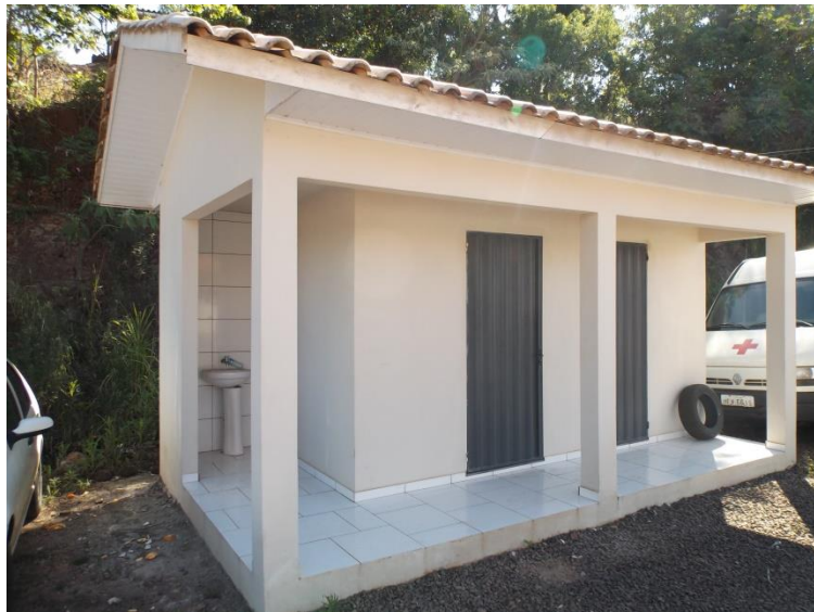
Figura 51. Local de acondicionamento dos resíduos do serviço de saúde em Saltinho. Fonte: Vigilância Sanitária de Saltinho/SC (2016).
