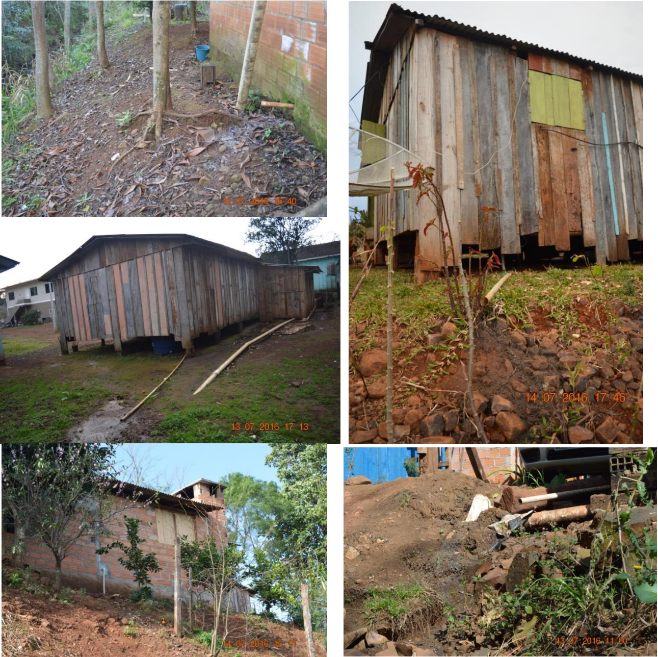
Figura 42. Fotos de residências com lançamento parcial de esgoto a céu aberto.
