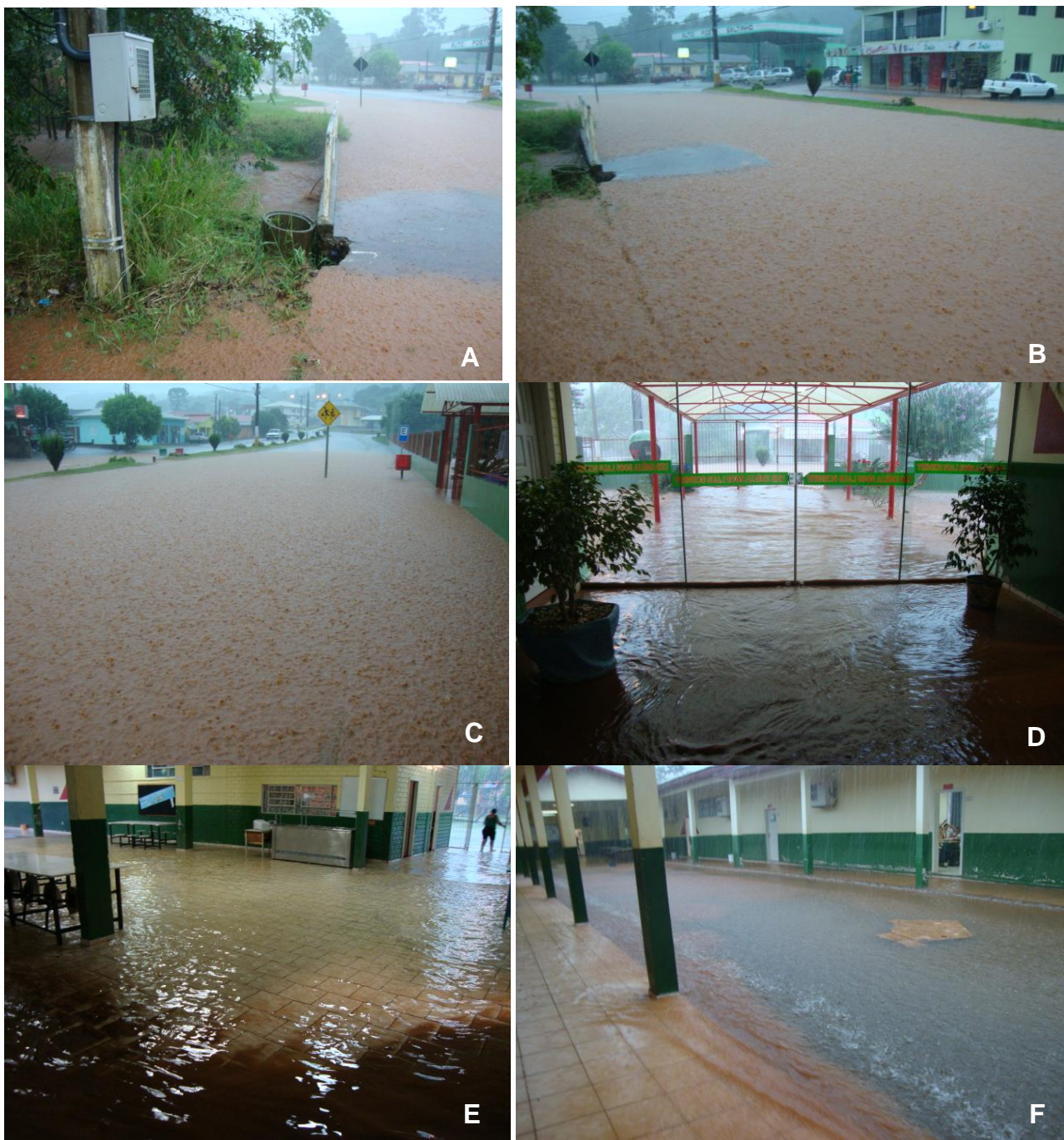
Figura 74. A, B e C - Evento de inundação do Rio Urutau atingindo as edificações às margens, como a Escola Estadual Urbana Emília Boos Laus Schimdt na Avenida Alfredo J. Scopel. D, E e F – Interior da Escola Estadual Urbana Emília Boos Laus Schimdt que sofreu com o evento de inundação do Rio Urutau.
