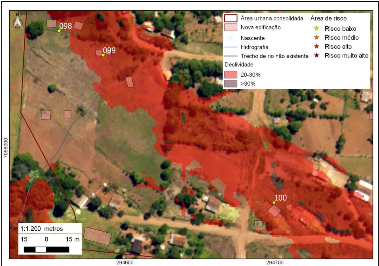
Figura 93. Edificação em baixo risco instaladas na vertente sem a manutenção adequada dos taludes.
