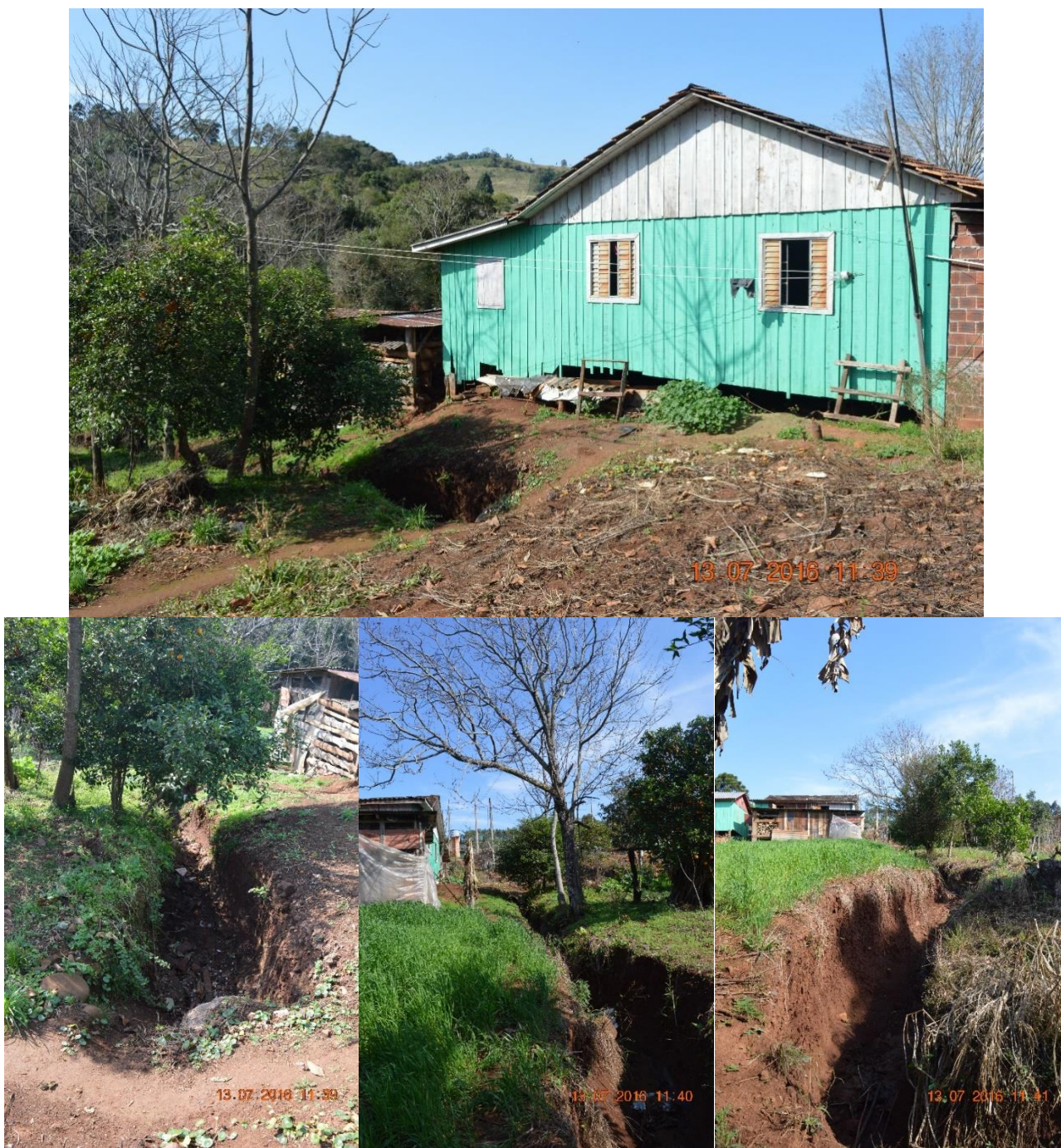
Figura 86. Imagens do Ponto 057 da Figura 77 , exibindo edificação próxima a um ponto de lançamento de água pluvial.
