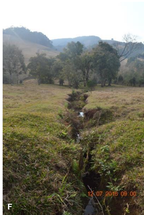
Figura 56. A - Ponto de lançamento de macrodrenagem ao lado de uma residência (Ponto 057, Figura 57 ). B - Vista de baixo para cima do ponto de lançamento. C - Erosão causada pelo ponto de lançamento (Ponto 126, Figura 57 ). D - Ponto de lançamento de macrodrenagem. E – Canalização de manancial com contribuição de drenagem pluvial da Rodovia SC-160 (Ponto 004, Figura 57 ). F - Sanga cuja água servida é direcionada.
