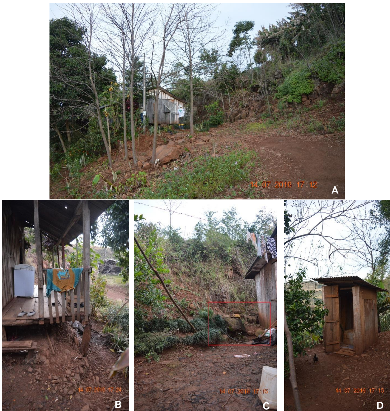
Figura 82. Edificação em área de risco localizada no cruzamento da Rua Arthur Balz e Rua Lindolfo Schwartz (Ponto 116, Figura 77 ).
