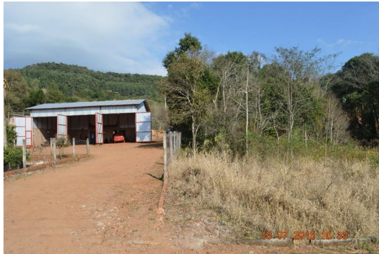
Figura 112. Edificação identificada em área de baixo risco às margens da Sanga Vermelha (Ponto 052 da Figura 111 ).
