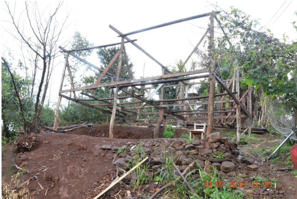
Figura 91. Edificação sendo construída para abrigar a família que residia na casa do Ponto 093.
