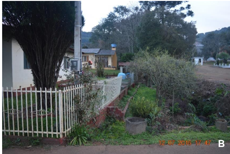
Figura 116. A - Estrutura de canalização da Sanga em processo avançado de assoreamento. B – Proximidade das edificações da Sanga Vermelha (Ponto 033 da Figura 111 ).
