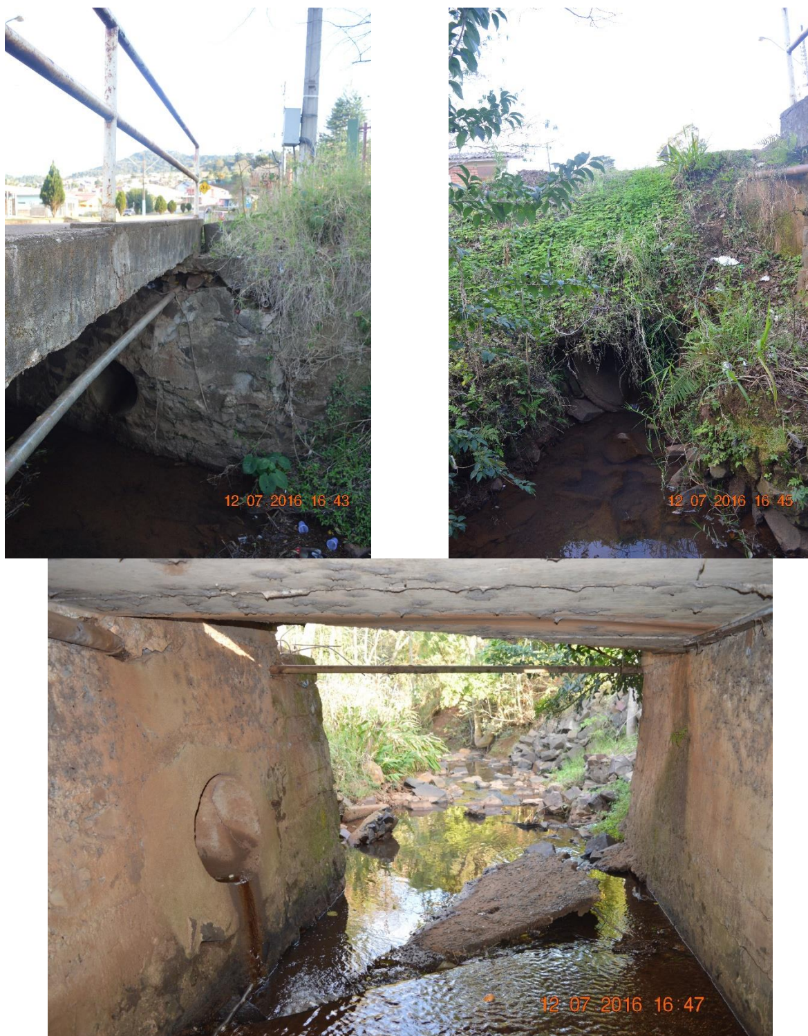
Figura 72. Pontos de lançamento de drenagem pluvial na canalização do Rio Urutau (Ponto 026).
