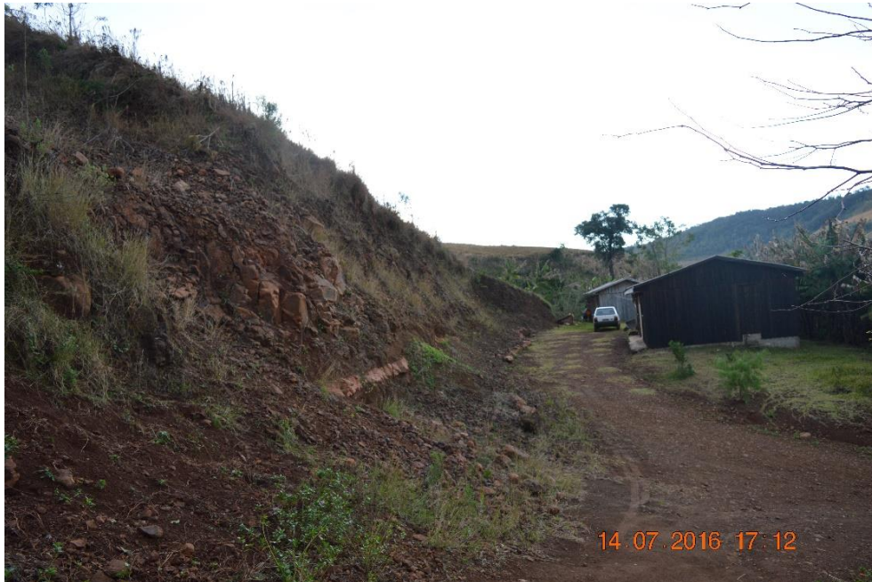
Figura 81. Edificações localizadas em região de alto declive (Ponto 118, Figura 77 ).
