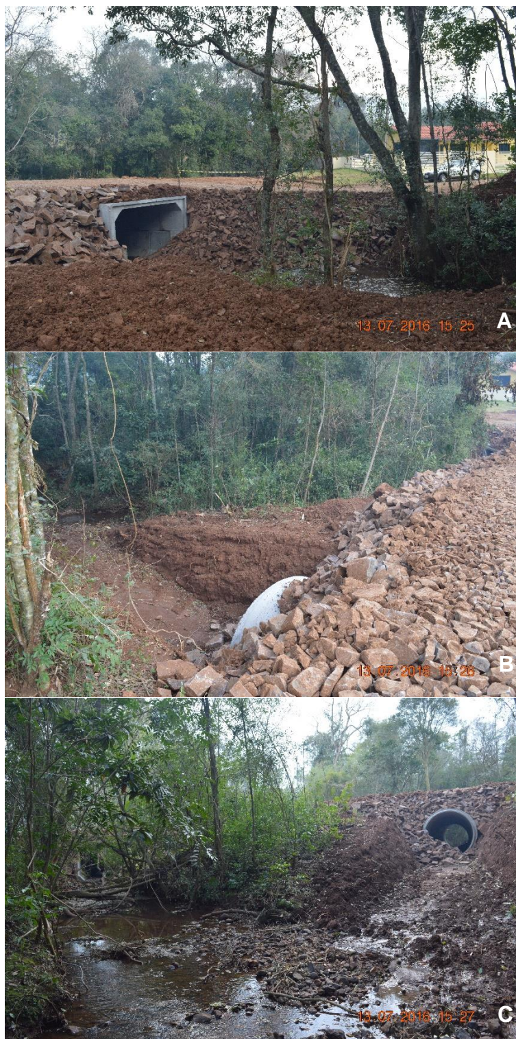
Figura 120. Estruturas de canalização do Rio Saltinho no trecho onde houve obra hidráulica de retificação do curso hídrico para prevenção de eventos de inundação do manancial.
