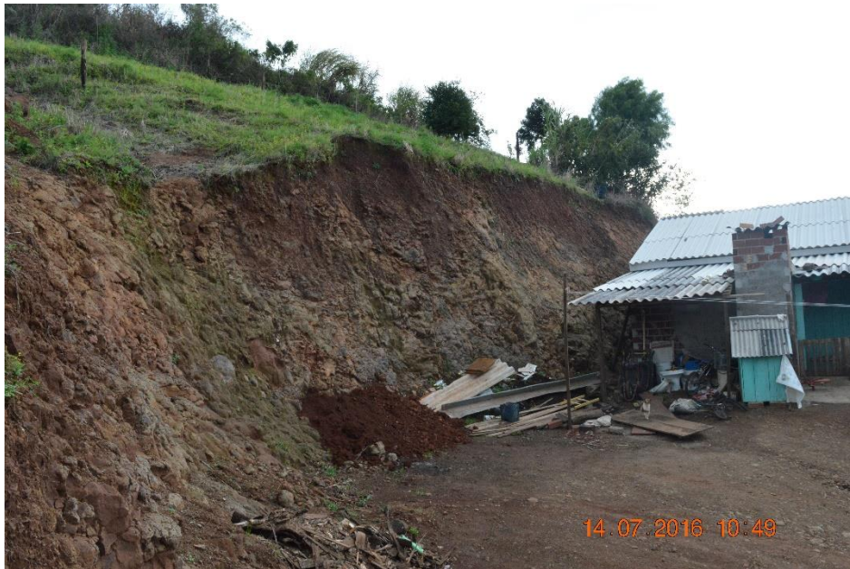
Figura 100. Edificação em área de baixo risco localizada no Ponto 090 da Figura 97 .
