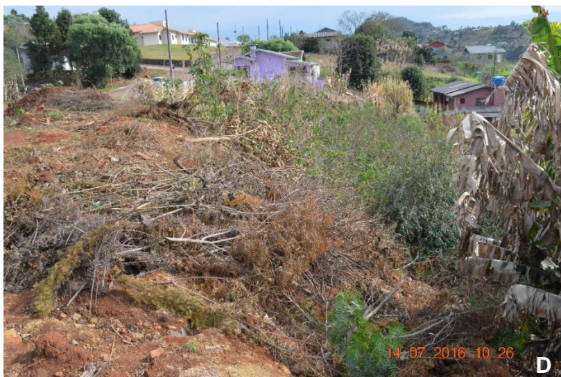
Figura 110. Área de corte e aterro em local de declividade acentuada criando uma área de risco.
