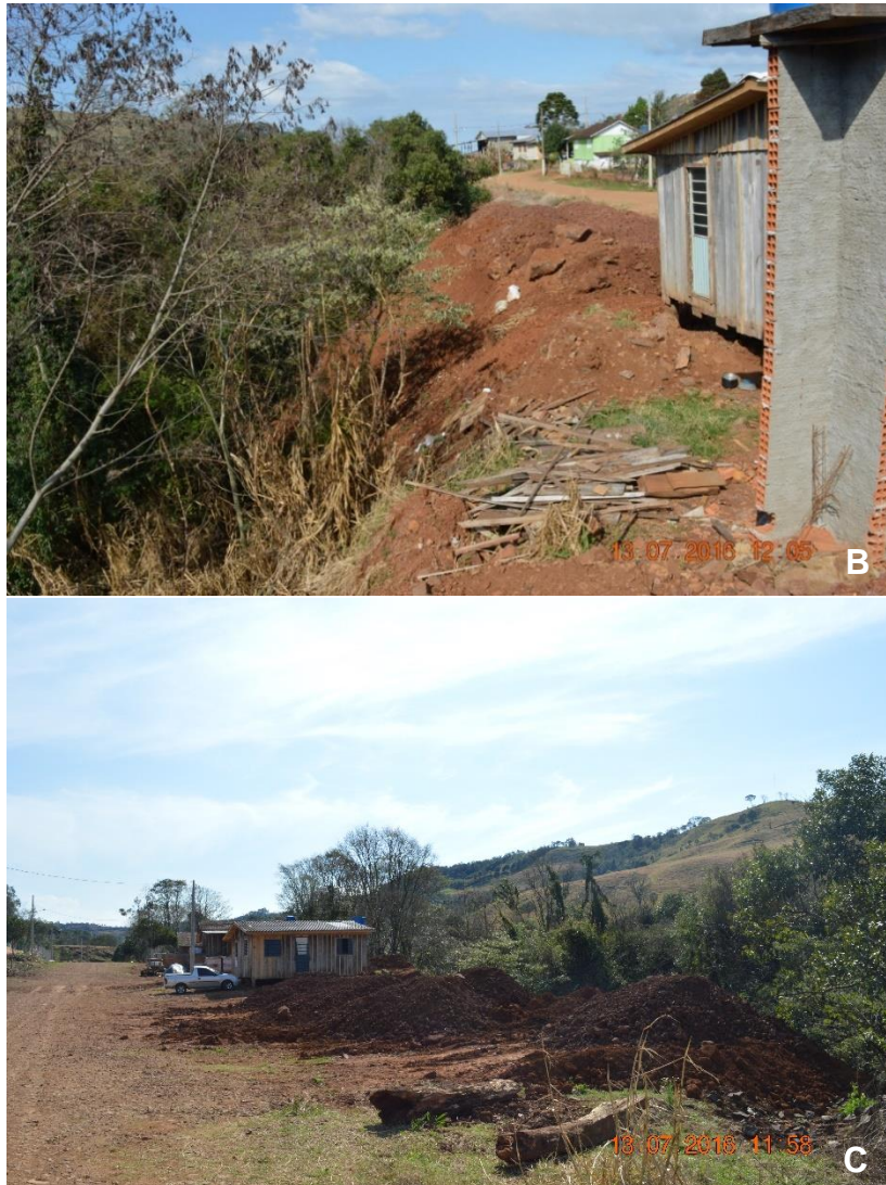
Figura 85. Edificação construída em área de aterro às margens do Rio Saltinho.
