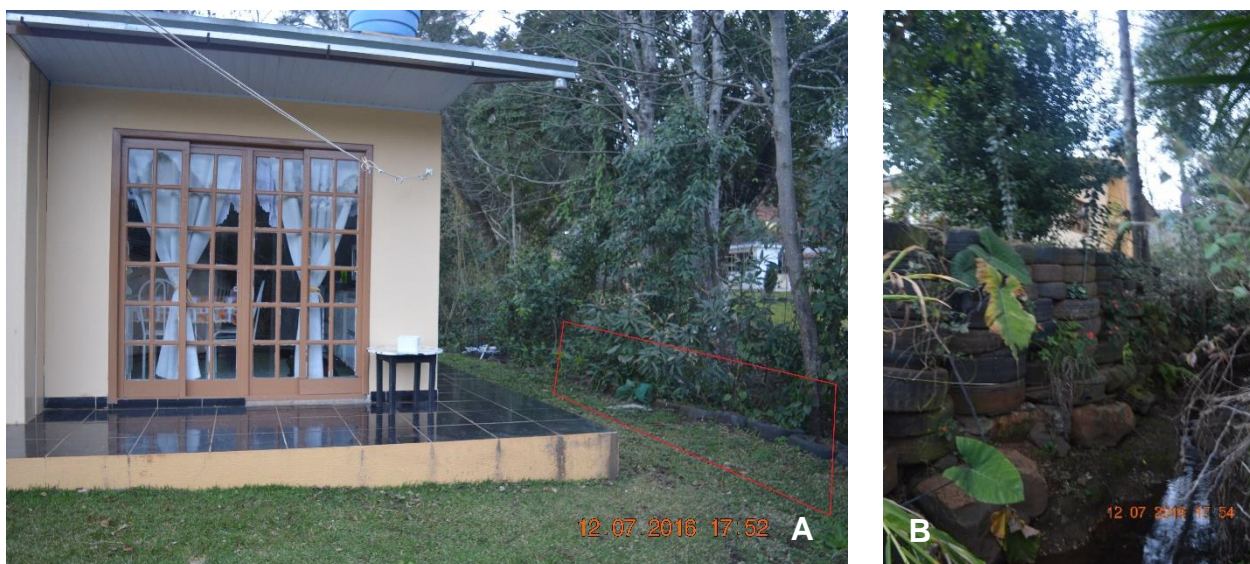
Figura 115. A - Edificação que já sofreu com eventos de inundação. B - Contenção instalada para prevenir eventos de inundação. Construções próximas ao Ponto 034 da Figura 111 .
