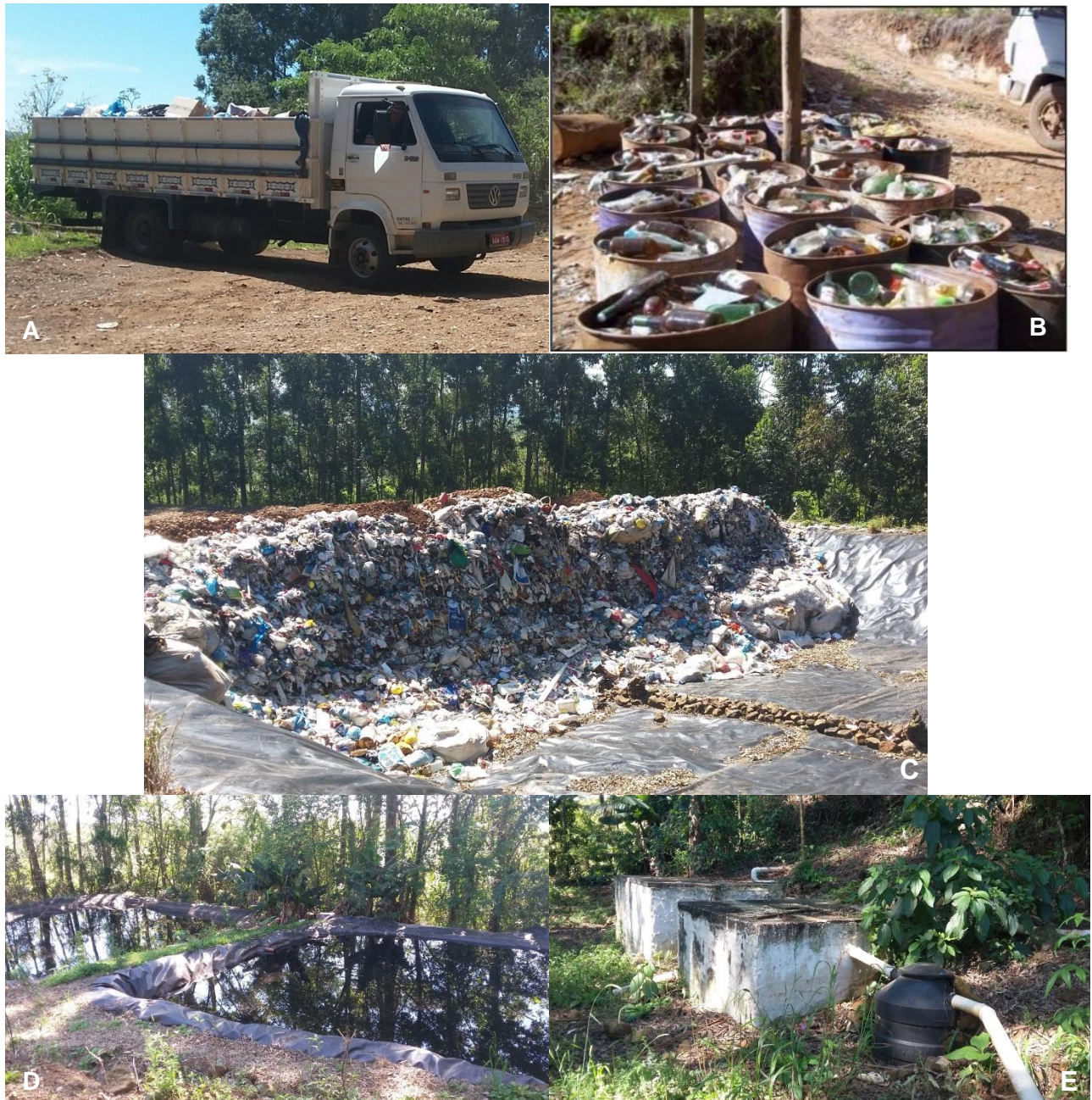
Figura 46. (A) Caminhão utilizado para coleta domiciliar em Saltinho/SC. (B) Recipientes utilizados para segregação de recicláveis. (C) Vala em operação do Aterro Sanitário da CW, em Bom Jesus do Oeste/SC. (D e E) Sistema de tratamento do chorume gerado no aterro sanitário da CW.
