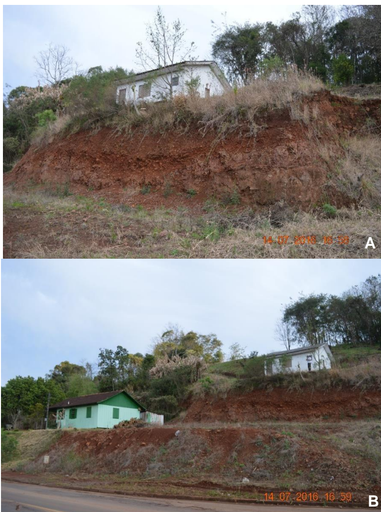
Figura 105. Área de risco classificada como baixo/manter local em observação identificada como Ponto 115 na Figura 103 .
