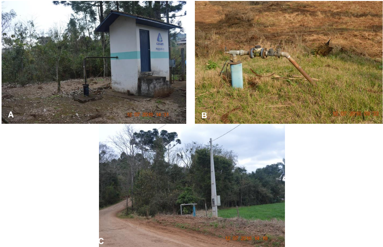
Figura 32. (A) Poço 1, (B) Poço 2 e (C) Poço 3.
