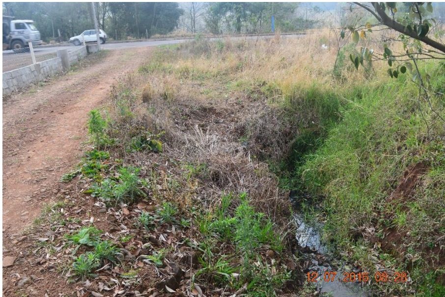
Figura 121. Área do início da canalização da Sanga sem nome na face norte da área urbana consolidada do Município de Saltinho, Santa Catarina.
