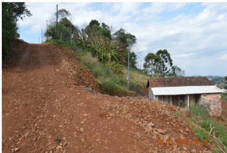
Figura 55. Estrada de chão com desnível negativo e moradia a direita do leitor. 99(475)
